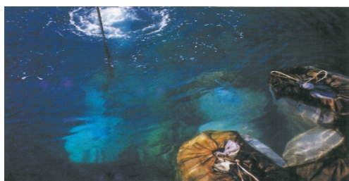
③水中にCAS材フレコンバッグを敷設します。 瞬時に固化するので水中作業は不要です。
