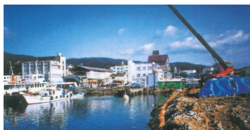
②フレコンバッグをクレーン車で水中に投入します。
