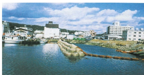
④海上基礎 設置完了
