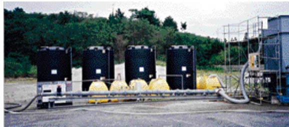
②CAS剤を乱流水の中に投入・攪拌。
