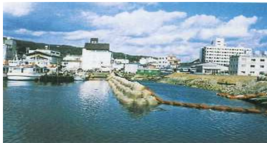
④海上基礎 設置完了
