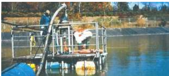
① 濁水を水中ポンプにて吸上げ、乱流発生装置に送る。
