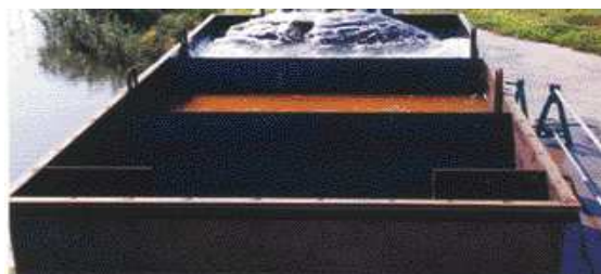
③ 沈殿槽を通しフロックと処理水 (清水) に分離します。
